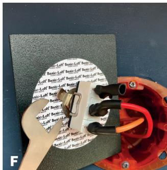
Serrez l'écrou de serrage (4) avec la clé plate.
