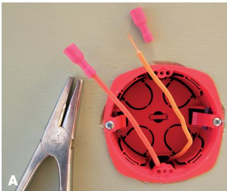
A Glissez les cosses sur les fils dénudés de 10mm. Sertir avec une pince à sertir ou une pince plate
