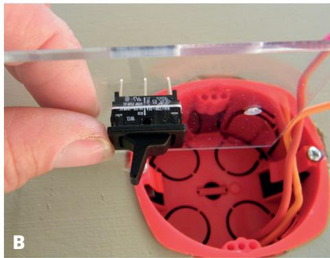
B Clippez l'interrupteur délicatement à la main par la face avant de la plaque
