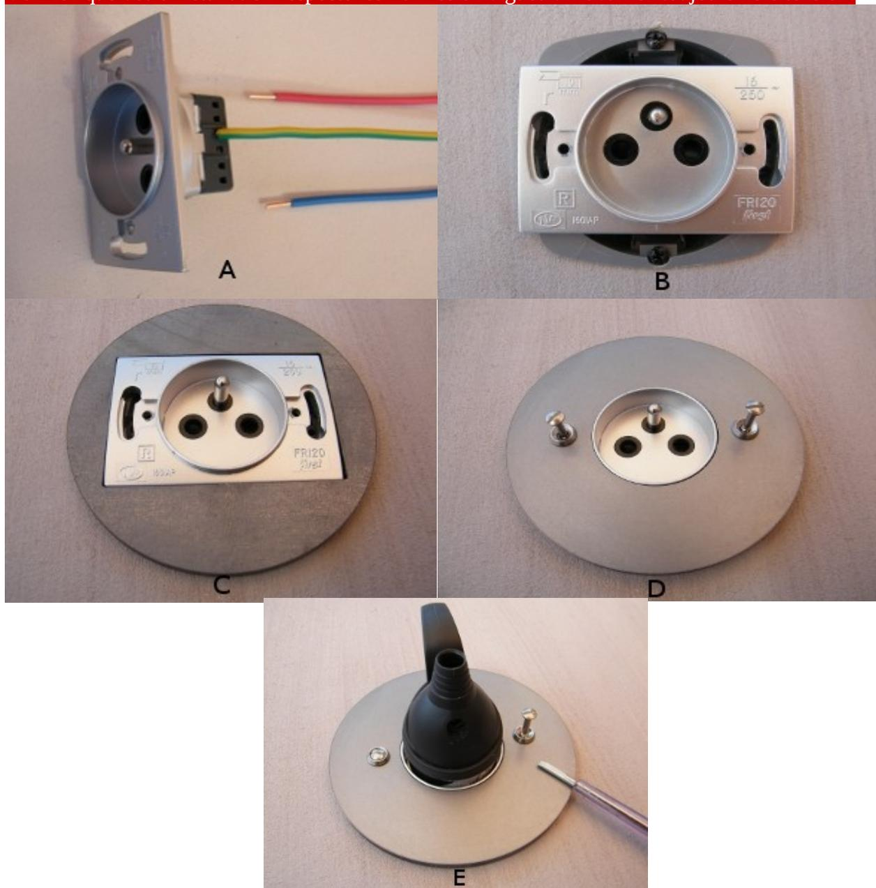
A- dénudez les fils sur 10mm et glissez les dans leur borne définitive au dos du bloc prise, le fil de terre se connecte au centre
